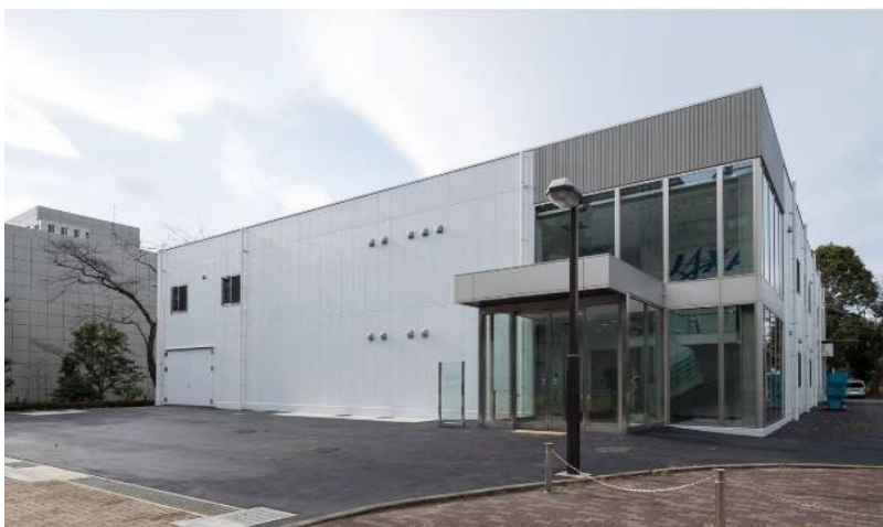
『宇宙探査実験棟』 月惑星表面を模擬した屋内実験場
