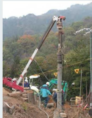
写真3 杭基礎工事例
