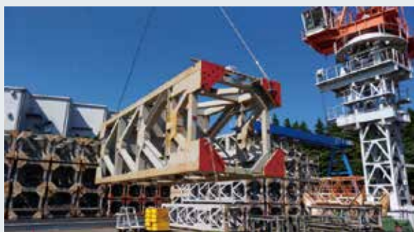
センサおよび墨出システムの検証実験
