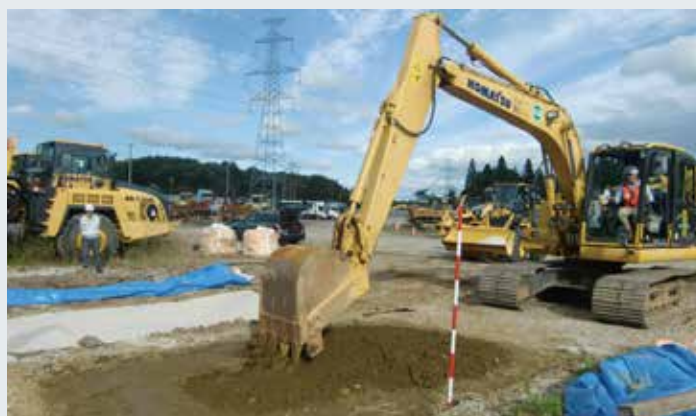
実機を用いた掘削実験
