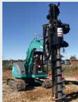
写真2 現場検証試験用の原位置掘削試験機
