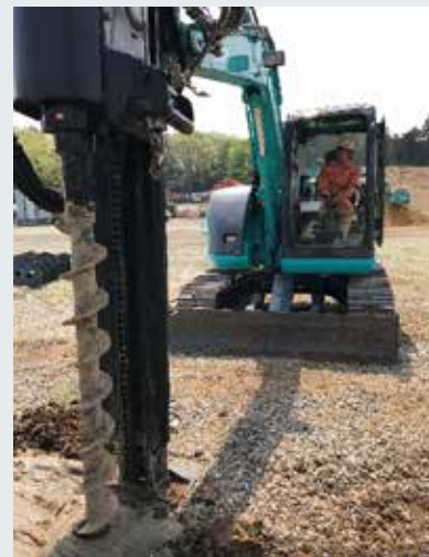
写真3 現場検証試験の状況（杭基礎工事をイメージ）
