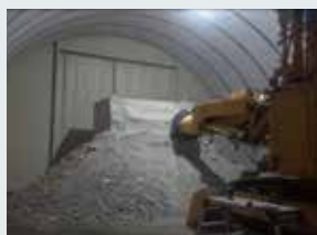
図3. 模擬トンネル試験場での実機掘削検証
