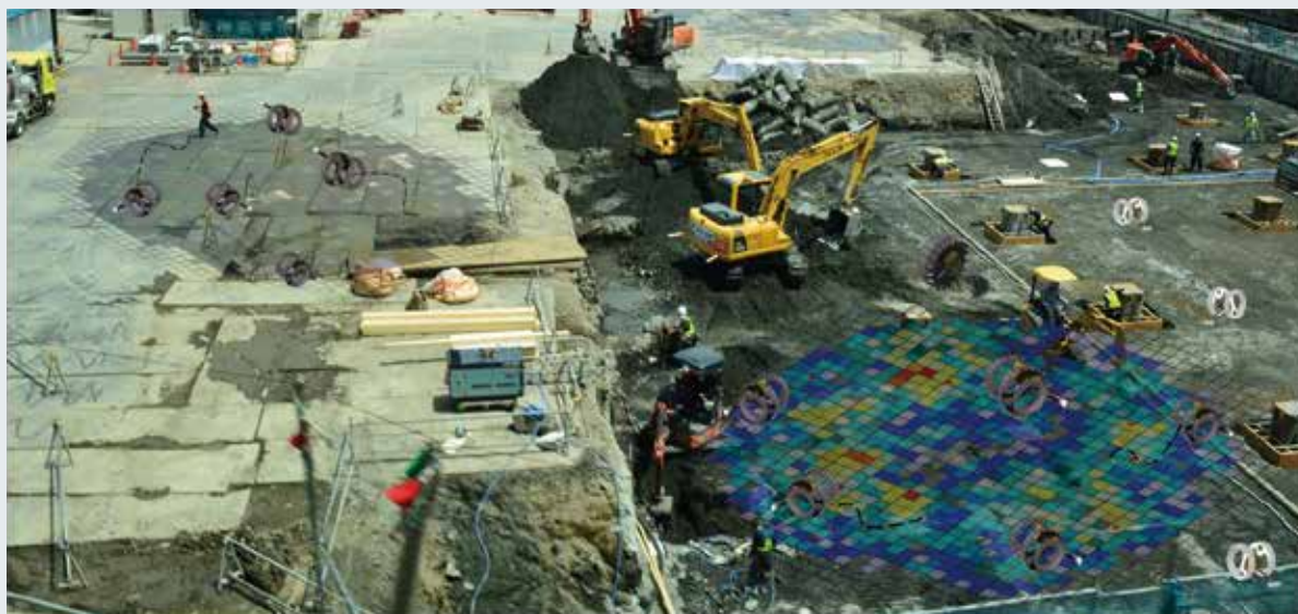
複数小型ロボットが協調し拡散するシステムを用いて、建設現場や老朽化インフラにおける、作業進捗確認やモニタリング、点検や調査を行います
