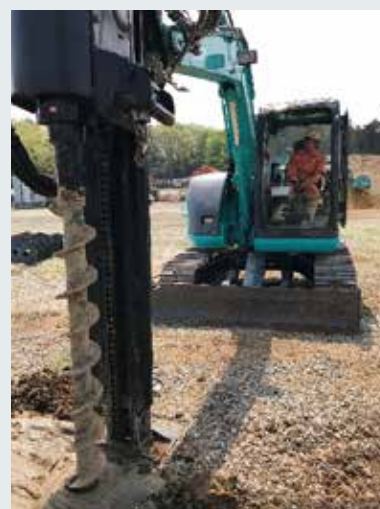
写真3 現場検証試験の状況 （杭基礎工事をイメージ）
