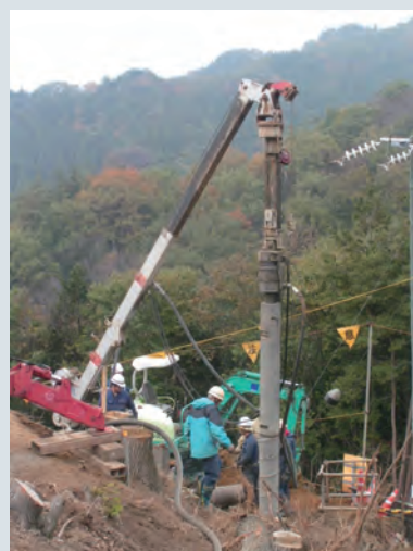
写真3 杭基礎工事例
