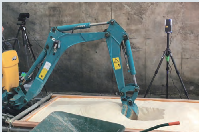
ミニバックホウによる掘削実験
