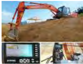
情報化施工 (日立建機ホームページより)
