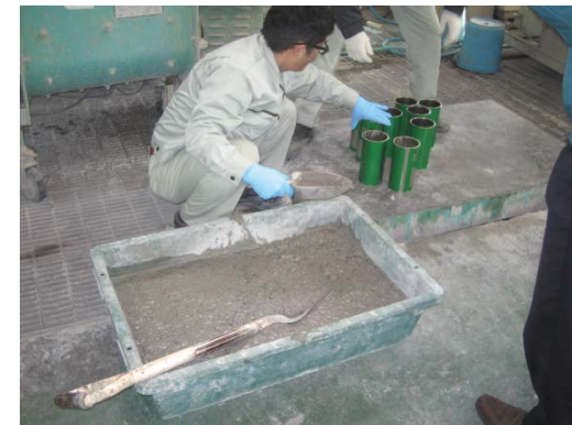
ジオポリマーの混練工程 西松建設HP:より抜粋
