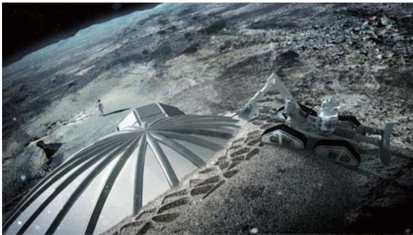
3Dプリンタ技術を使った拠点建設計画と実証実験 (Credit: ESA)
